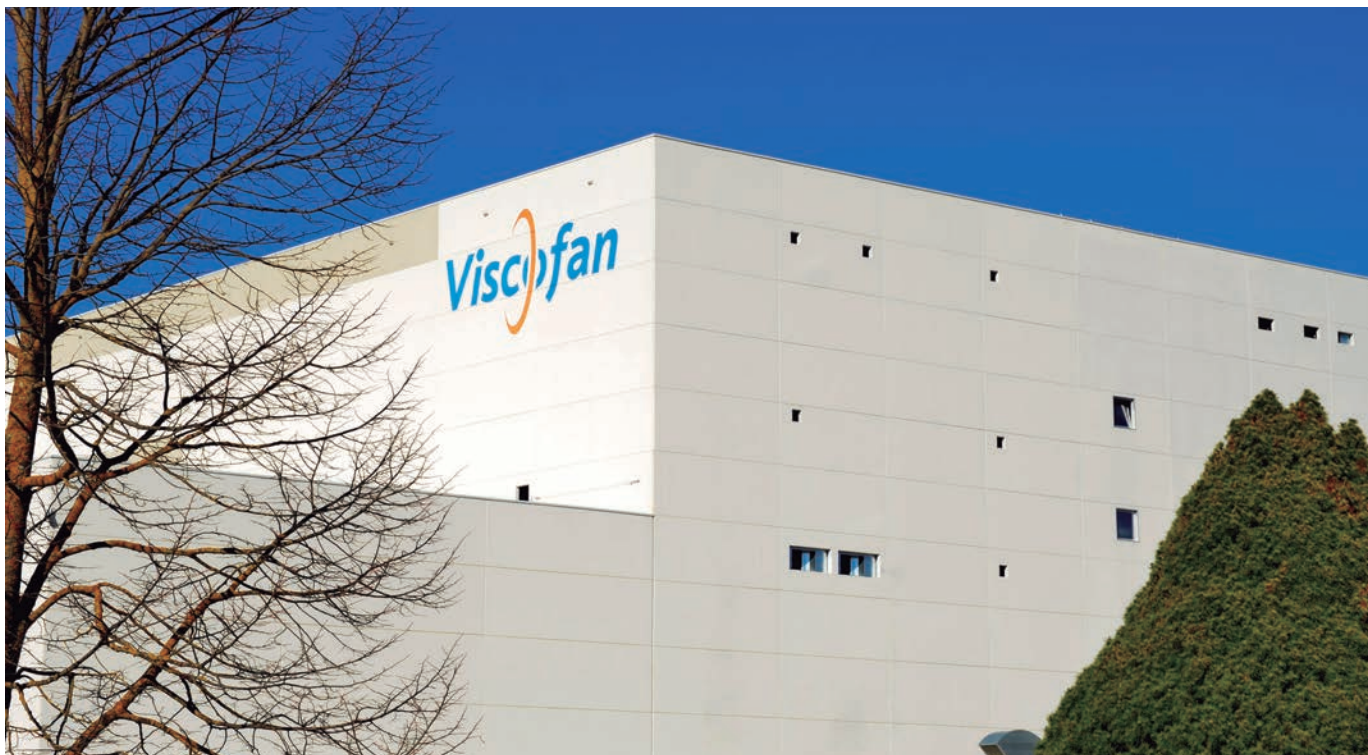
Fachada de la planta de Cáseda (España)
