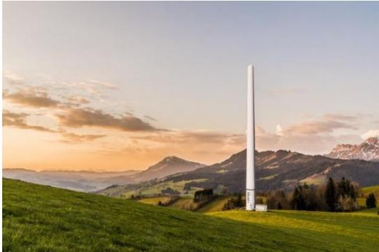
Vortex Bladeless S.L. desarrolla y comercializa **aerogeneradores eólicos que no necesitan palas, ejes, engranajes, rodamientos o mecanismos** que normalmente se desgastan por fricción.
