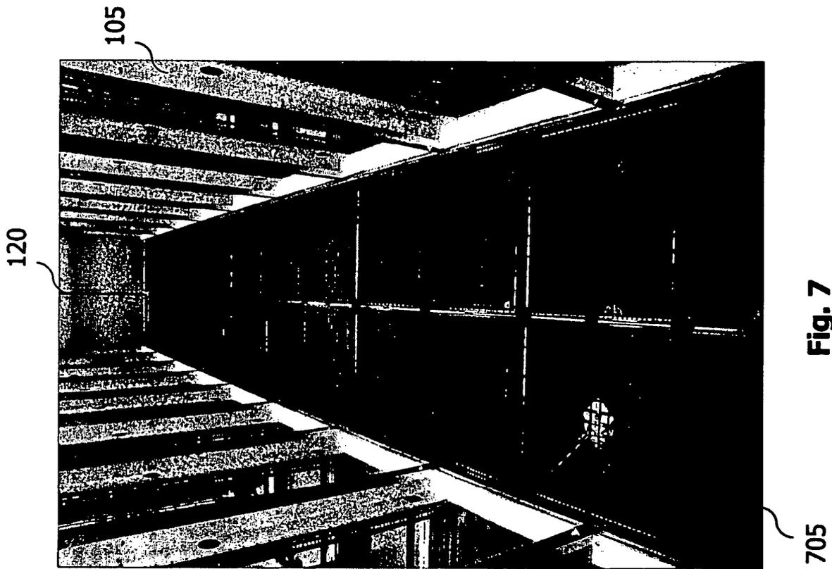
Distribución en planta de los bastidores con separación de pasillos frío y caliente
