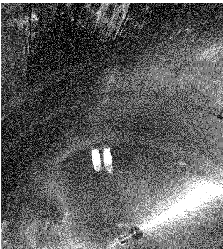
Tanque antes de la limpieza
